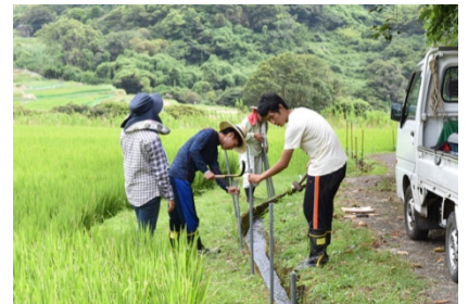
被害対策のための防護柵の設置
