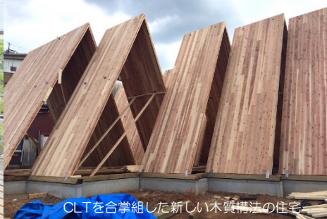
木の塊を外壁に用いた新しい木質構法の住宅
